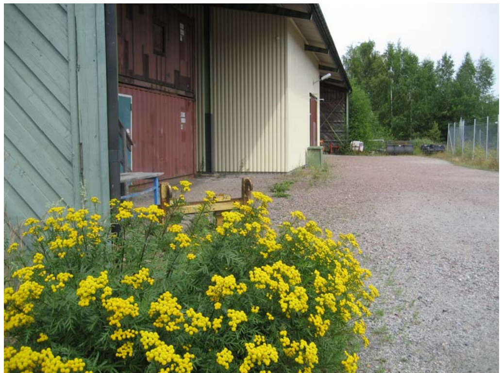
Förrådsbyggnad Hammarö utbildningscenter (maskinhall).
