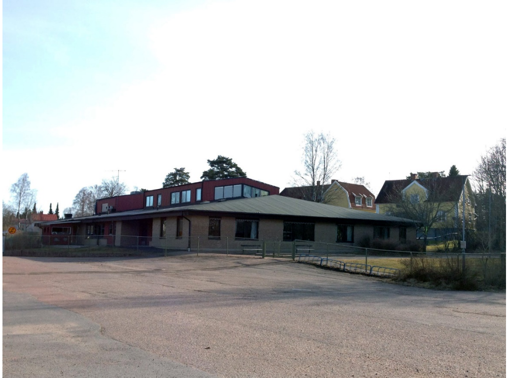
Vy över kvarstående skolbyggnad sett från sydväst
