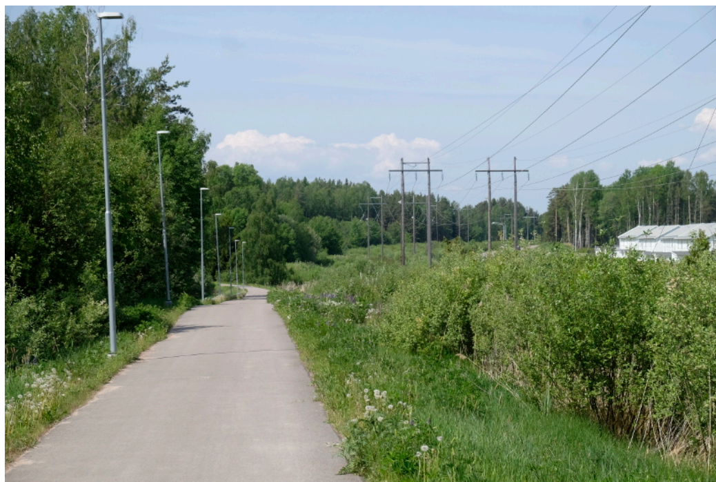
Foto över delområde f med kraftledning till höger i bilden.
