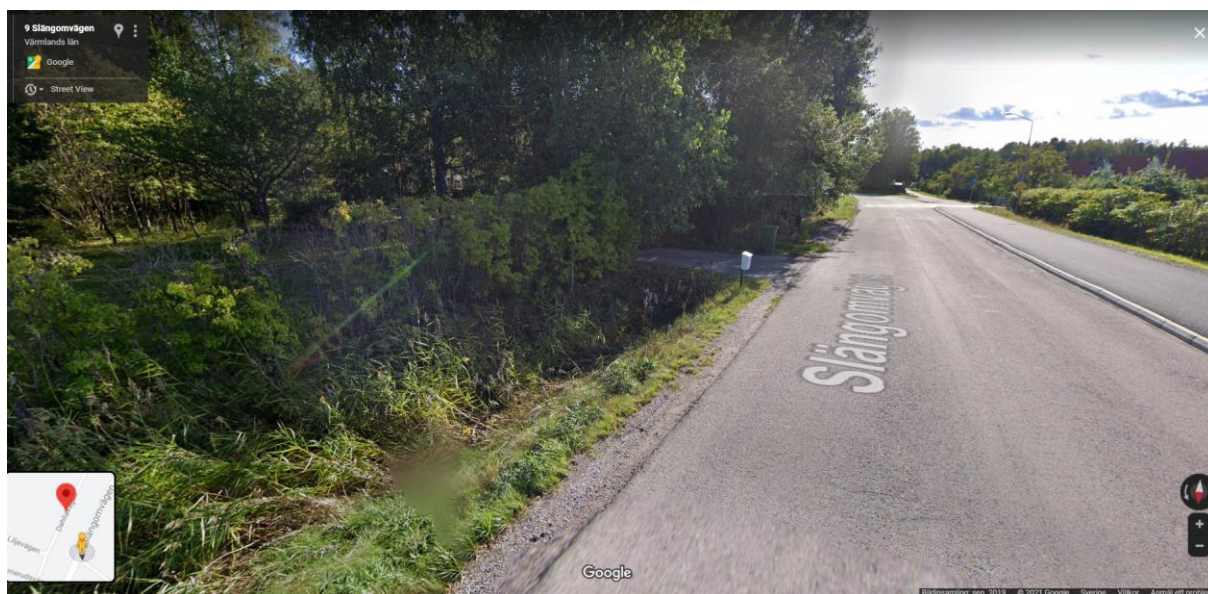
Figur 7.2 Befintligt dike längs planområdet där Scalgo identifierat en möjlig översvämning. Diket bedöms kunna hantera avledningen söderut.
