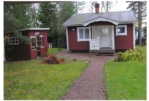
Bråten 1:34. Fritidshus och grillstuga med stående lockpanel i allmogestil.
