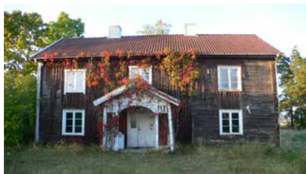
Nolgård 1:344, som ligger mellan Nolgårdsvägen och Hammaröleden mot Karlstad, har tidigare varit nämndemansgård och är den äldsta och enda mangårdsbyggnaden på Nolgård som bevarats i ursprungligt skick. Huset är ursprungligen från 1700-talet men byggdes om på 1860-talet till en parstuga med kök i mitten.
