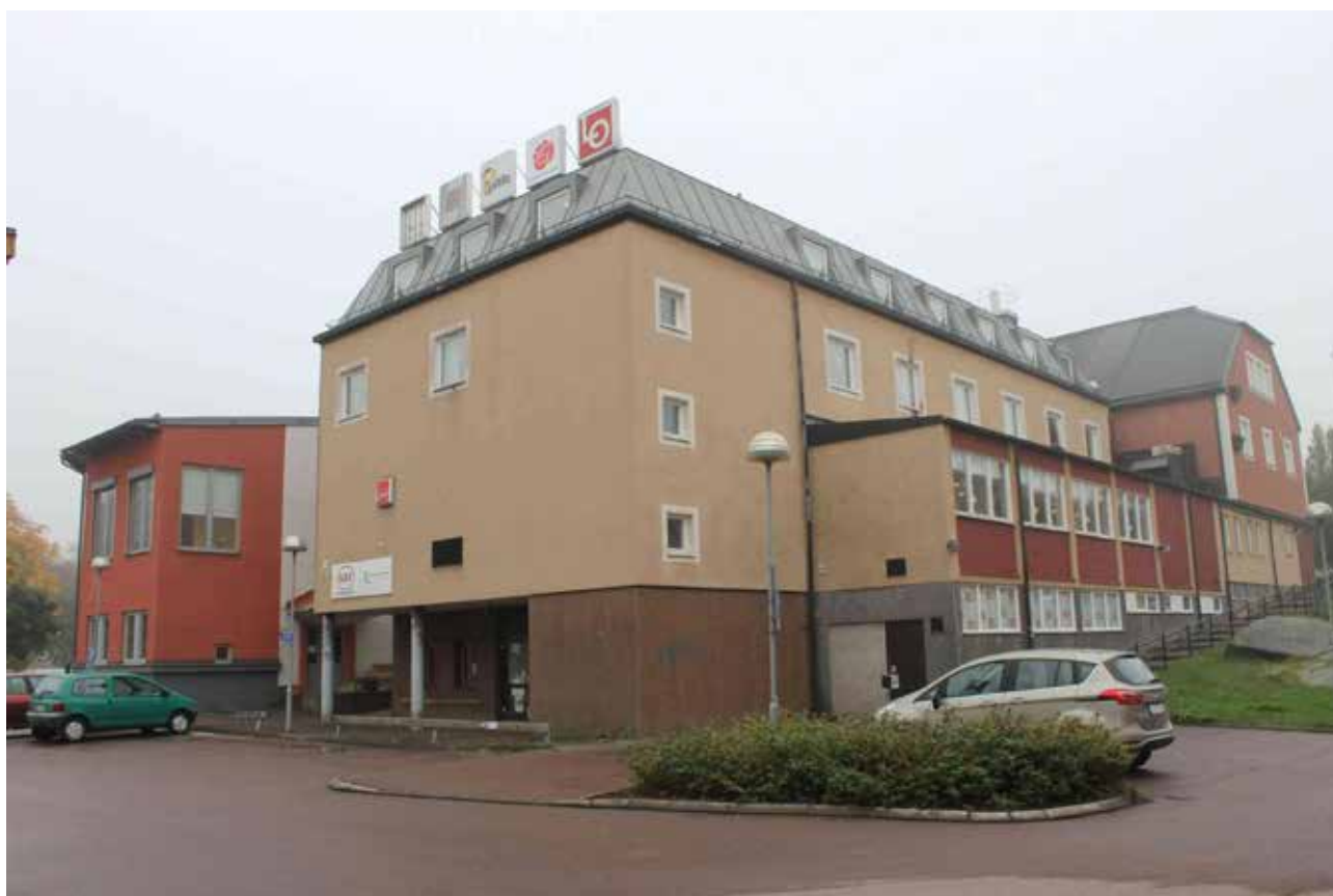
Folkets hus norra fasader där man tydligt kan se de olika tillbyggnaderna som gjorts. Entrén låg ursprungligen på norra fasaden där tillbyggnaden från 1957 gjordes.
