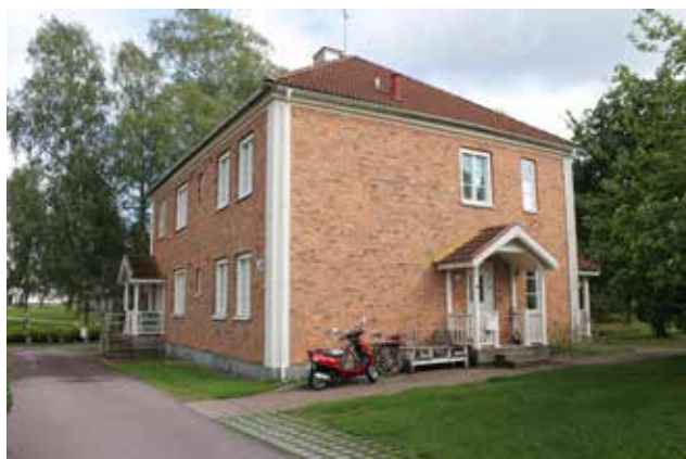
Ett av husen utmed Bruksgatan i nyklassicistisk stil. Här syns två av de fyra separata entréer om finns.
