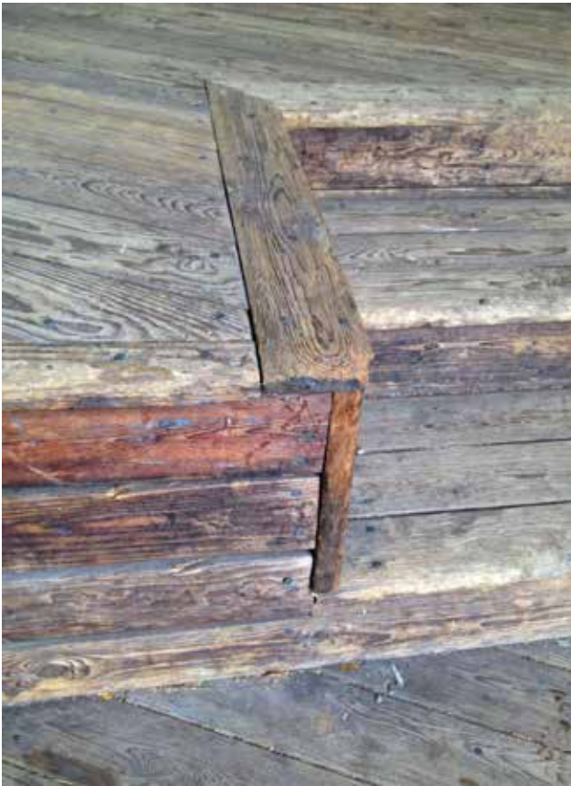
Detalj av scenen och scentrappan.
