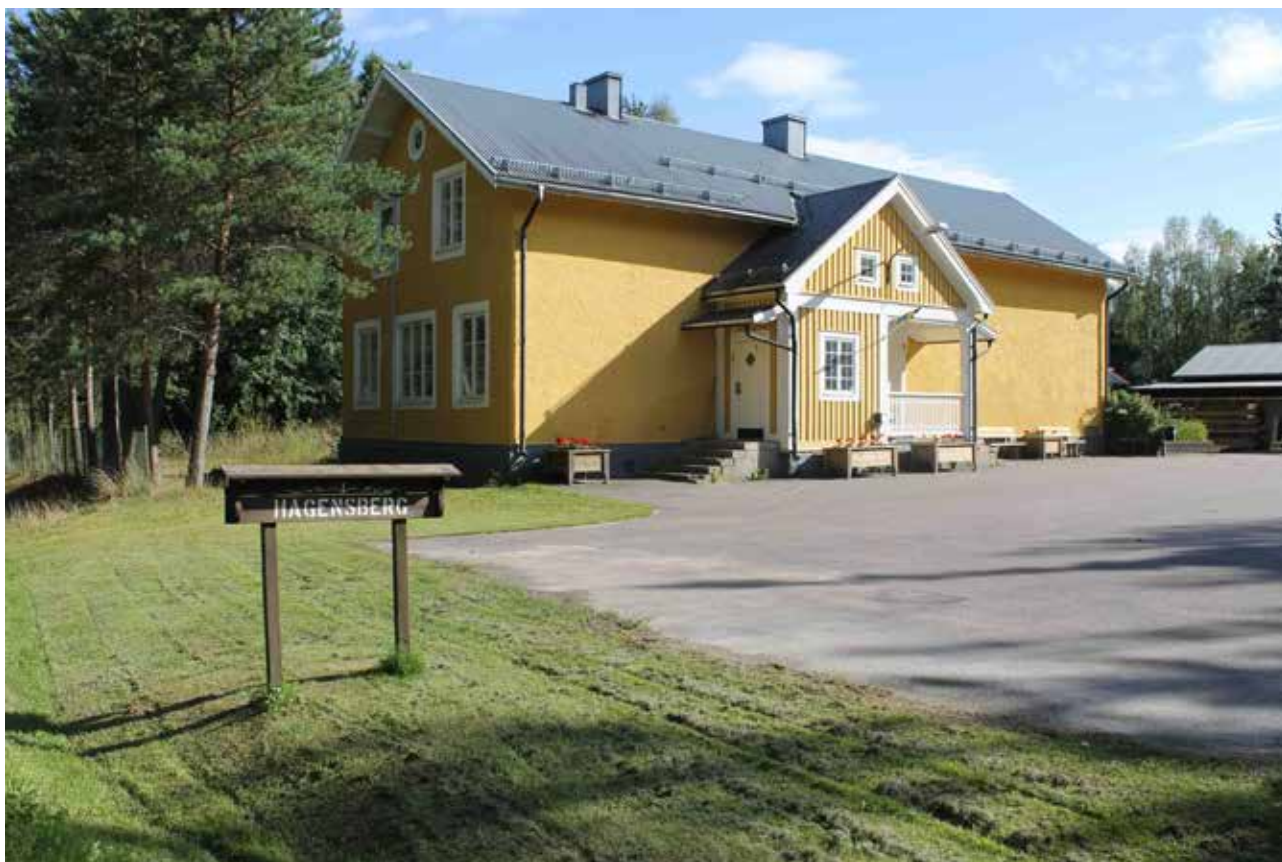
Skolbyggnadens västra fasad med farstutillbyggnaden. På östra fasaden sitter de höga valvade skolfönstren kvar.
