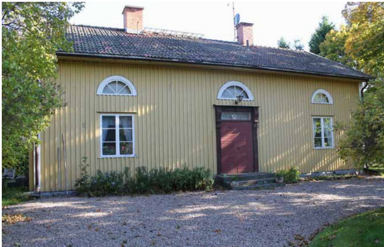
Manbyggnaden åt väster. På äldre foto kan man se att det tidigare fanns en förstukvist vid entrén. Förstukvisten hade frontepulpettak och var försedd med lövsågerier.
