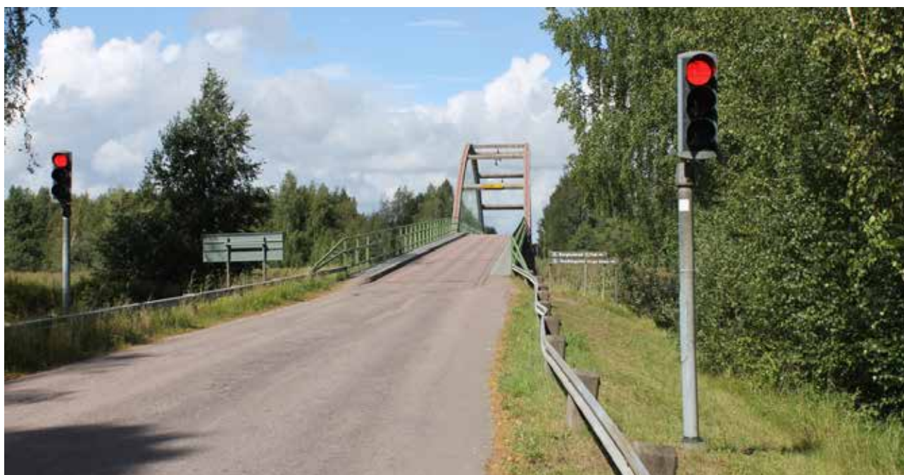
Bron från Hammarösidan. Foto mote nordväst.
