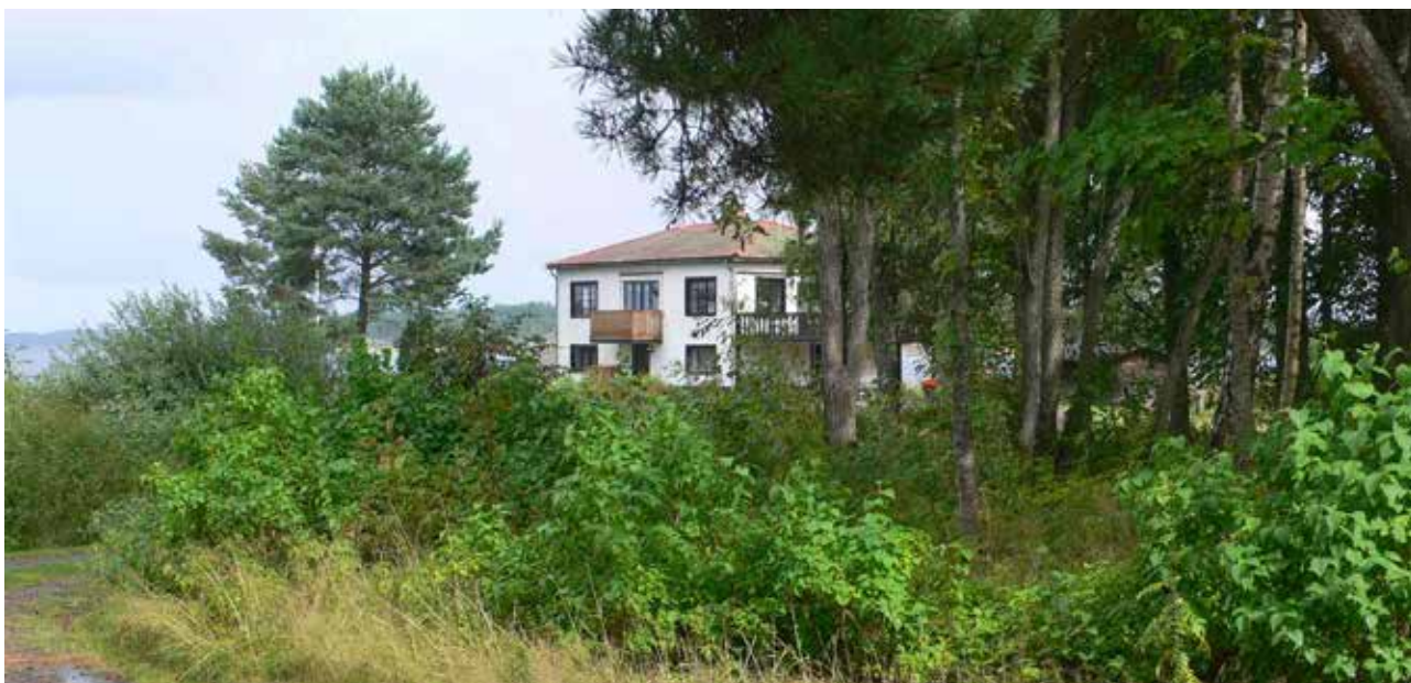
Västra Tye 1:102 - Koskär. Huset ligger längst ut på udden.
