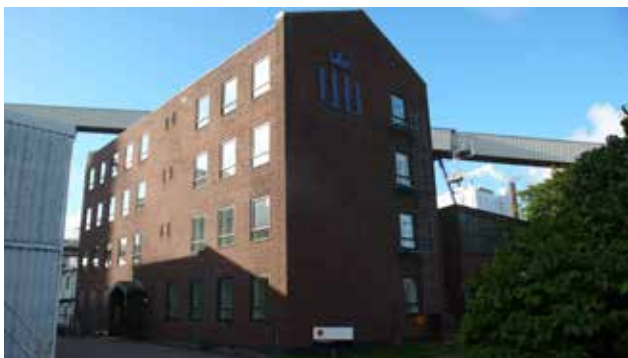
Anläggningskontoret, fd forskningslaboratoriet. Till höger: trappuppgång med tidsenligt utförande.
