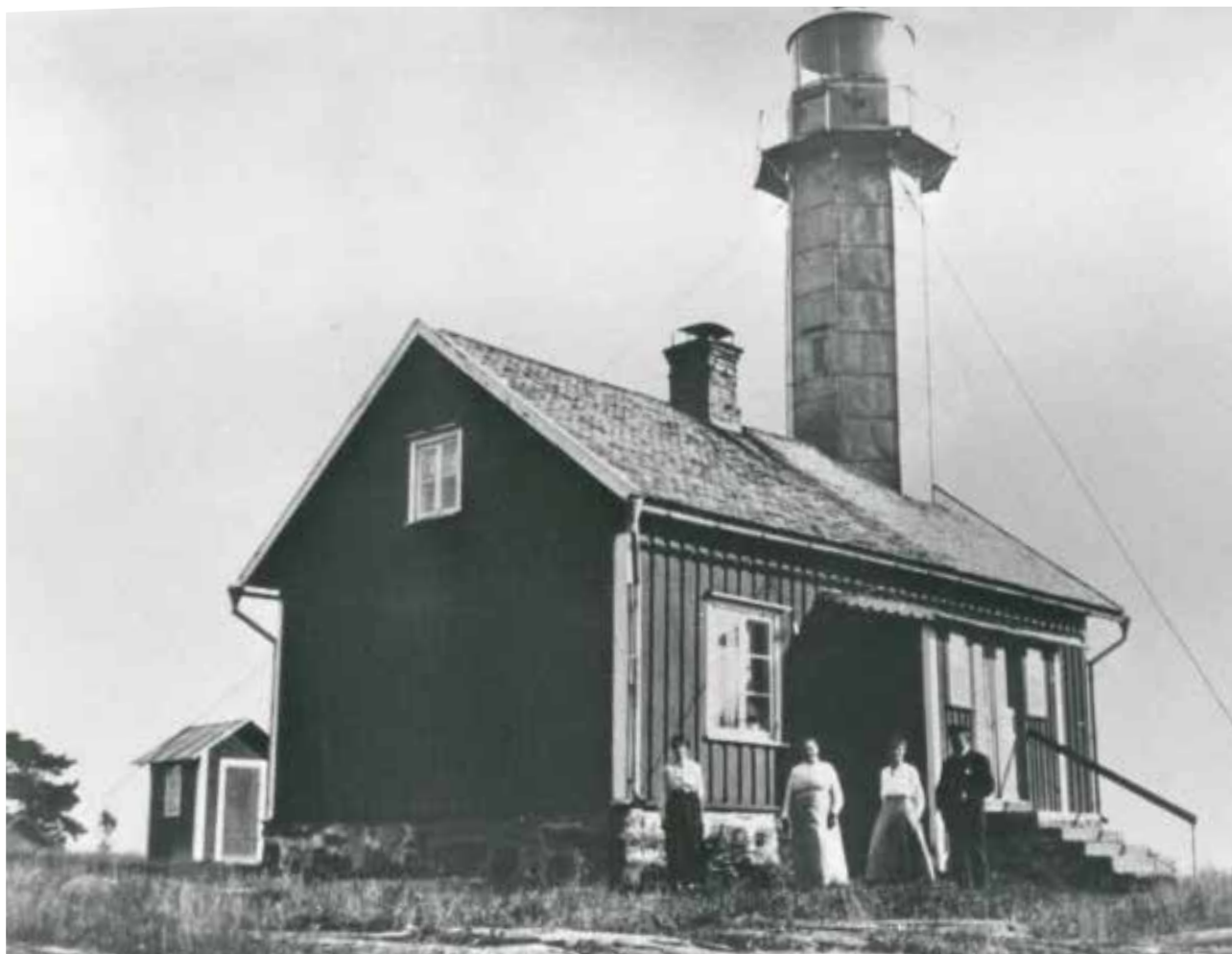
Söököjans fyr och oljebod i början av förra seklet. Framför huset står fyrvaktaren med familj. Här ses de ursprungliga spröjsade fönstren och en fönsterförsedd farstu med tvådelad spegeldörr. Foto: Hammarö hembygdsförenings arkiv
