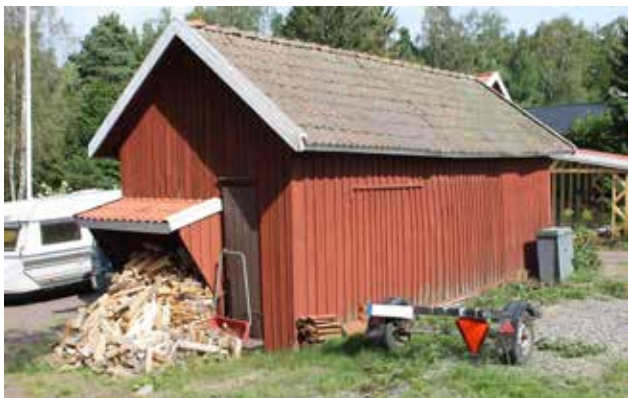
Ett äldre uthus på Skolvägen.
