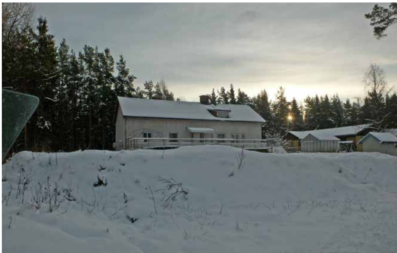
Fd ordenshuset för IOGT-logen 'Hammarös fäste' i Hallersrud, nu privatägd bostad.
