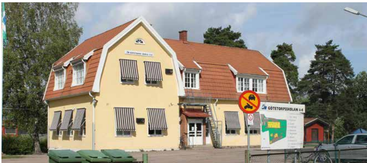
Den ursprungliga skolbyggnaden med två huskroppar i vinkel och mansardtak.
