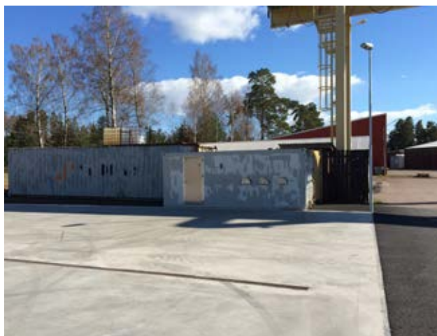
Ovan: Ny spolplatta med rening under uppförande. Sörvikshamnen, bild från sommaren 2014.
