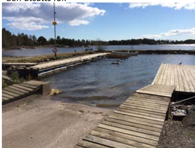
Ovan: Exempel på flytande brygga (t.v.) och vågbrytare (ovan, t.h.)
